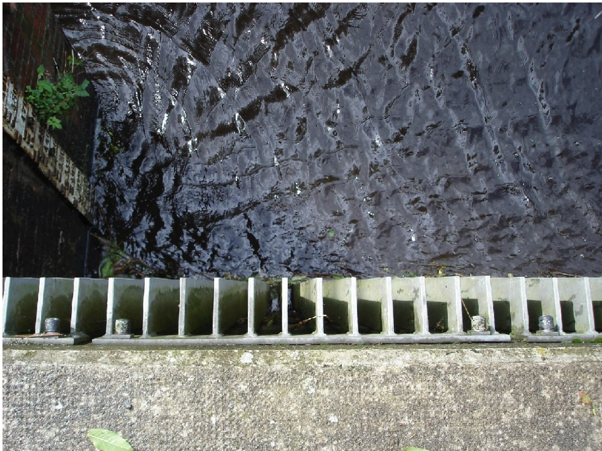
Schöpfwerk Broklandsau, lichte Breite der Gitterstäbe 5 cm Foto: Franke, ALR Kiel – Ast Husum 29. August 2008
